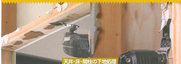
天井・床・間柱の下地処理
