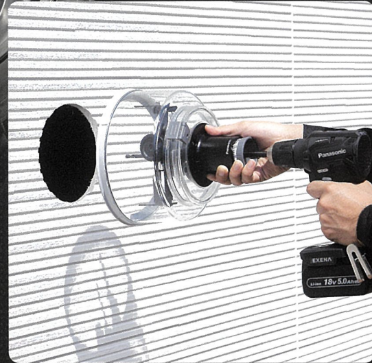
外壁 窯業系サイディング材 (φ160 mm)
